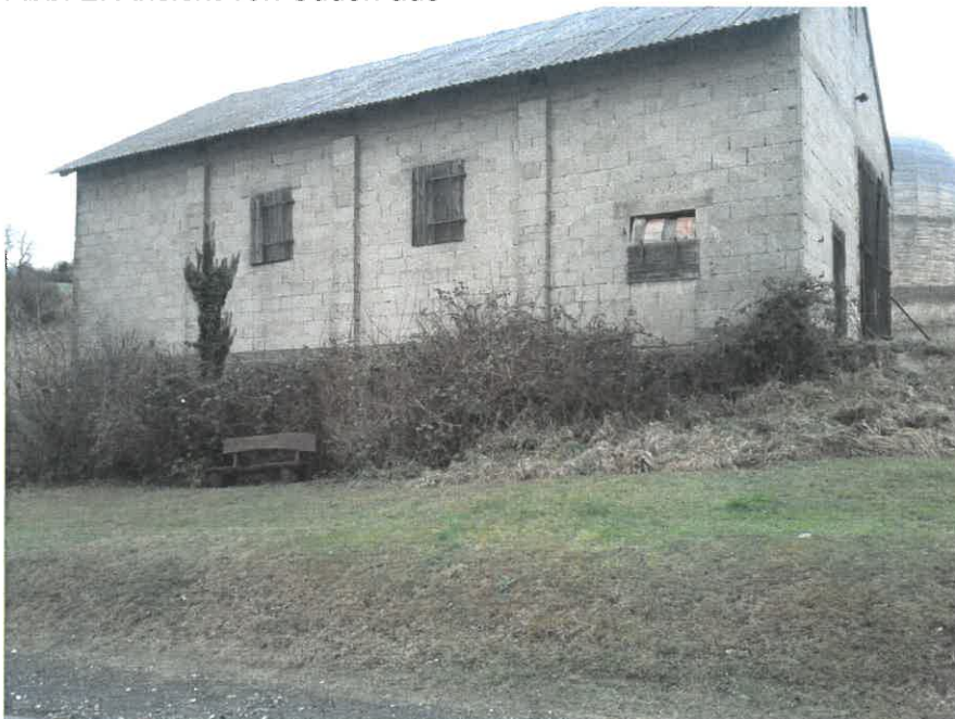
Abb. 2: Ansicht von Süden aus
