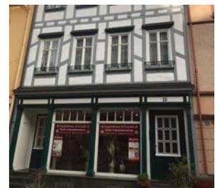
Holzfenster-Konstruktionen, die plastisch gegliedert werden, können diese Gestaltungsaufgabe besser erfüllen als Aluminium- oder Stahlkonstruktionen.
