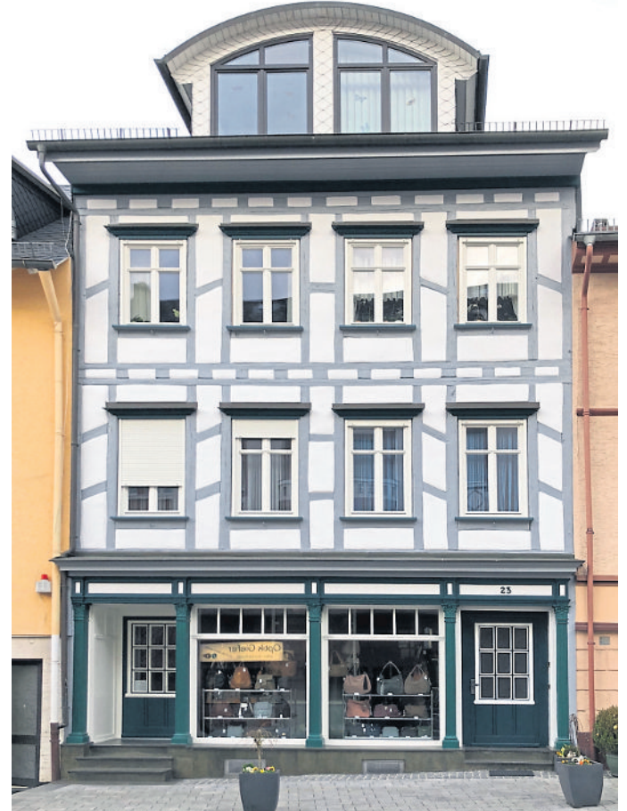
Albert House in der Brunnenstraße 23 nach der Sanierung Fotos: Uly Foerster
