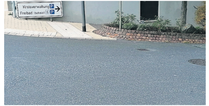
Nach und nach verschwinden Barrieren an Straßenübergängen. Fotoquelle: Stadt Bad Schwalbach
