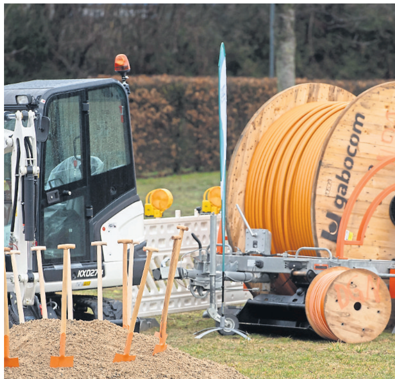
500 Meter Kabel schafft eine Baukolonne am Tag
